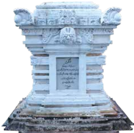
Gambar 4.18D – Foto Pilar Menghadap Utara.
